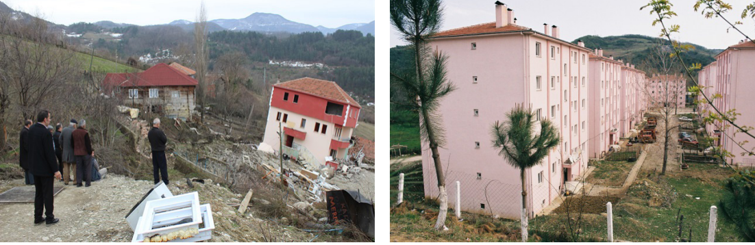
Foto 4. Sinop-Türkeli köylerinde yaşanan heyelanlar sonucu yıkılan meskenler ve bu tür felakete maruz kalan vatandaşlarımız için ilçe merkezine inşa edilmiş olan afet evleri.
