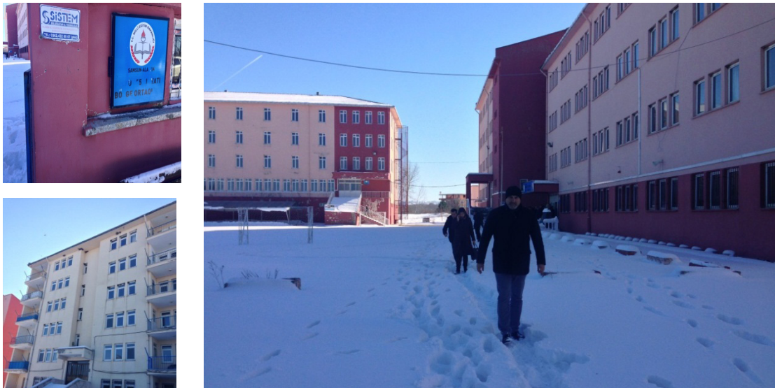
Foto 3. Samsun-Alaçam Göçkün köyü yatılı bölge okulu. Devasa yapı pansiyonu ve öğretmen lojmanları ile hayalet bina olmuş. Bir süre eğitim verdikten sonra öğrencisi olmadığı için kapanmış. Mevcut öğrenciler köylerden servislerle buraya gelmek yerine Bafra ve Alaçam ilçe merkezlerini tercih etmişler.
