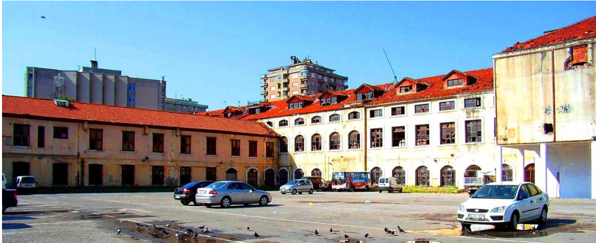
469. Eski Tekel Sigara Fabrikası (Restorasyondan önce).
