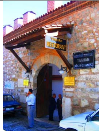
343. Vezirköprü - Taş Han, taç kapı (restorasyondan sonra).
