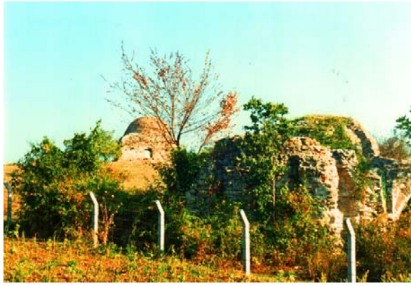
387. Bafra / Çetinkaya Beldesi - Hızır Bey Hamamı, güneydoğudan.
