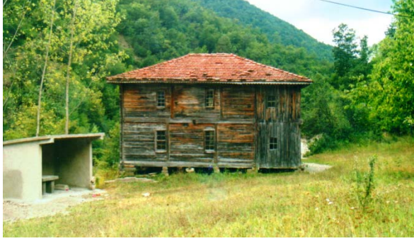
635. Asarcık / Yarımcı Köyü Camii genel görünüş.
