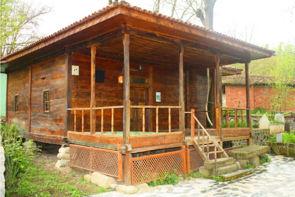
211. Kavak / Çakallı Beldesi - Kasımzâde Sofu Ahmed Camii, kuzeydoğudan.
