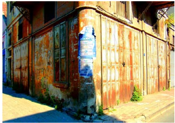
609. Hançerli Mahallesi'nde İskele Caddesi'nin batı kolu üzerinde bulunan bir dükkân.
