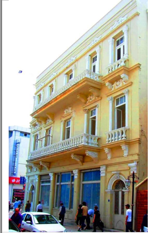
502.Eski Saray Oteli (Eski İmar Bankası) ön (doğu) cephe.
