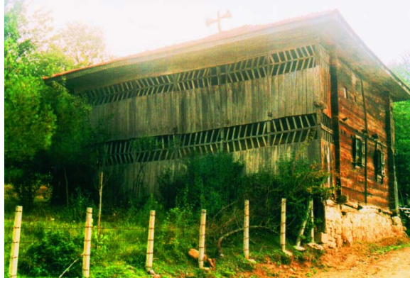
154. Asarcık / Klavuzlu Köyü Camii, batı ve güney cepheler.
