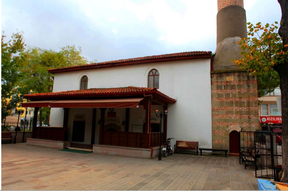
169. Bafra - Tayyar Paşa Camii, kuzey cephe.
