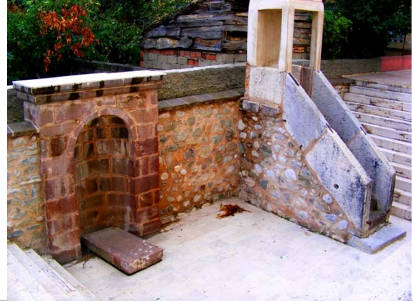
386. Vezirköprü - Köprülü Mehmet Paşa Namazgahı, minber ve mihrabı.
