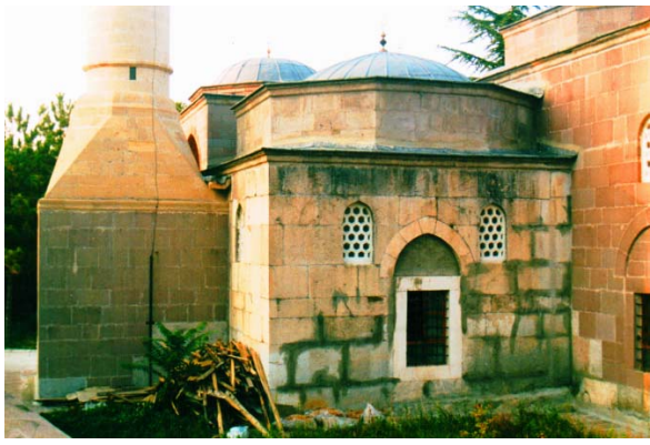
53. Vezirköprü - Taceddin İbrahim Paşa Camii, batı tabhane hücresi.
