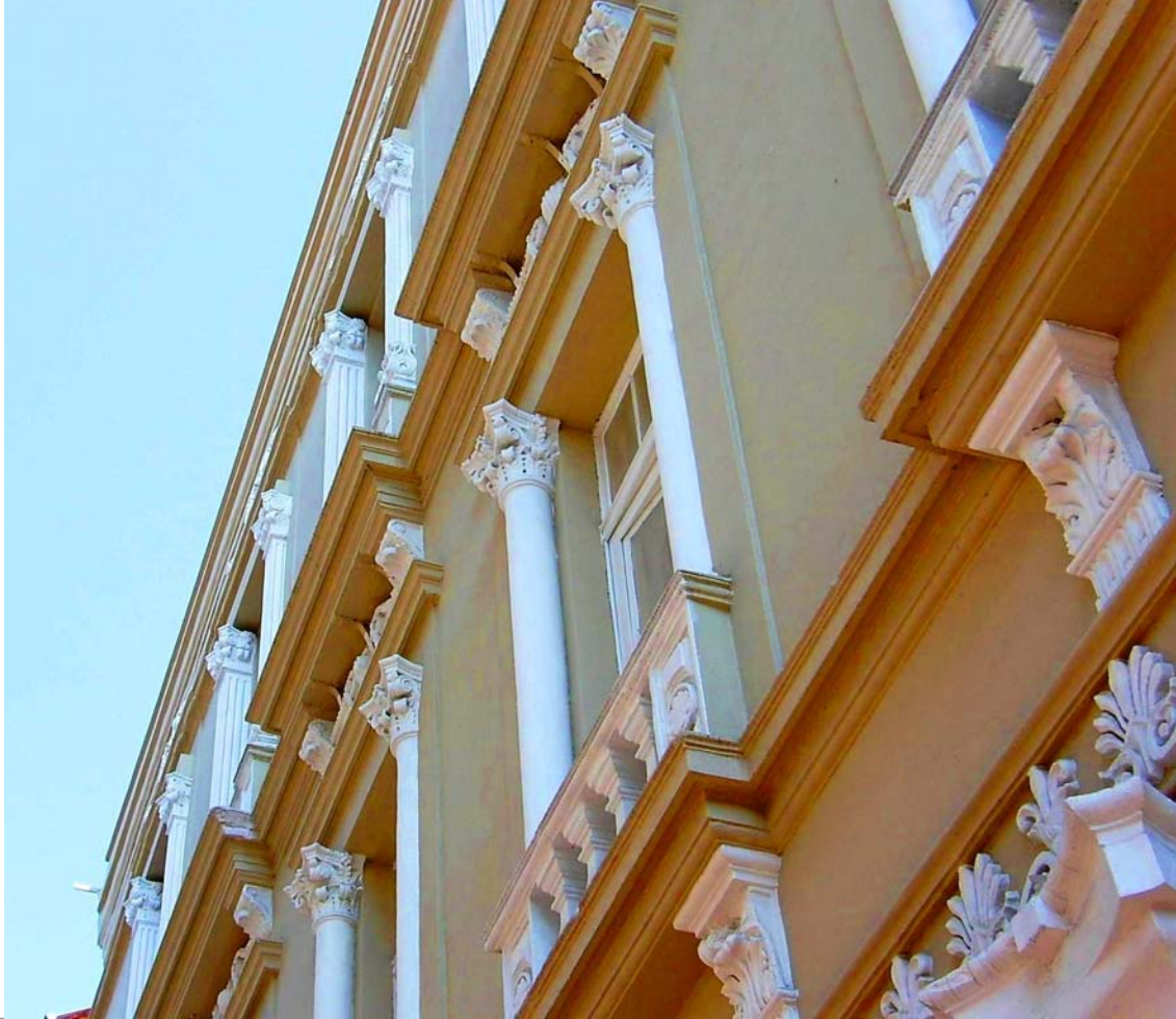
504. Eski Saray Oteli (Eski İmar Bankası), güney cephe.
