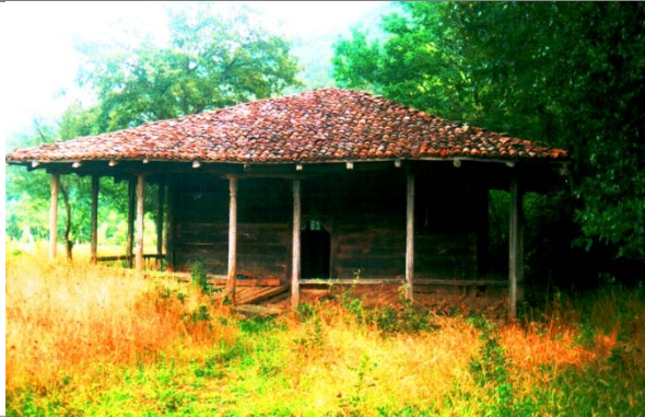
174. Kavak / Değirmencili Köyü - Dere Camii, kuzey cephe.
