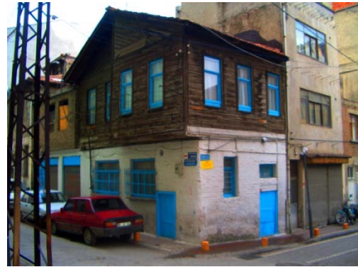
570. Saitbey Mahallesi'nde eski bir ev.
