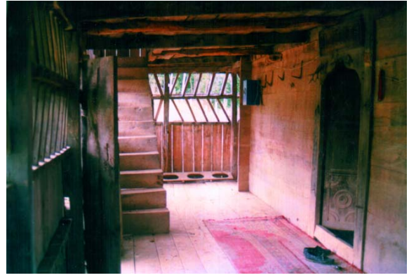
155. Asarcık / Klavuzlu Köyü Camii, son cemaat revakı.
