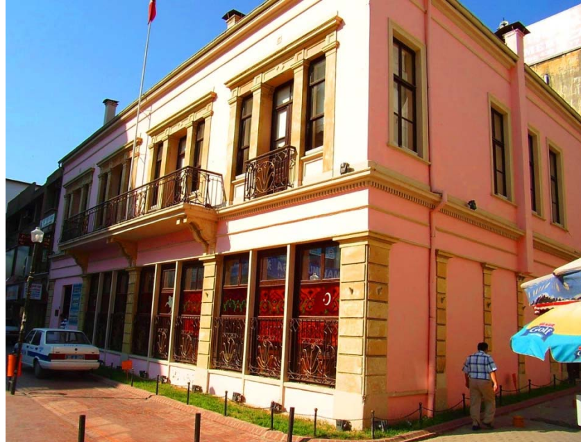
484. Gazi Müzesi (Eski Mantika Palas Oteli), kuzey cephe.
