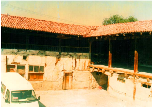
342. Vezirköprü - Taş Han, avlusu, kuzeybatı köşe (restorasyondan önce).
