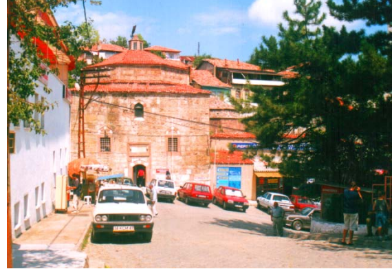
398. Havza - Kadınlar (Aslanağzı) Kaplıcası, güney cephe (soyunmalık).
