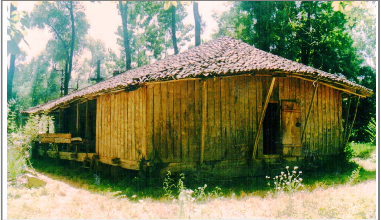
75. Terme / Dağdıralı Köyü Camii, kuzeydoğudan.
