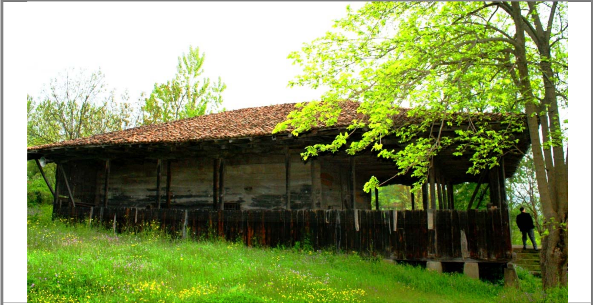
33. Çarşamba / Ordu Köyü Camii, doğu cephe.
