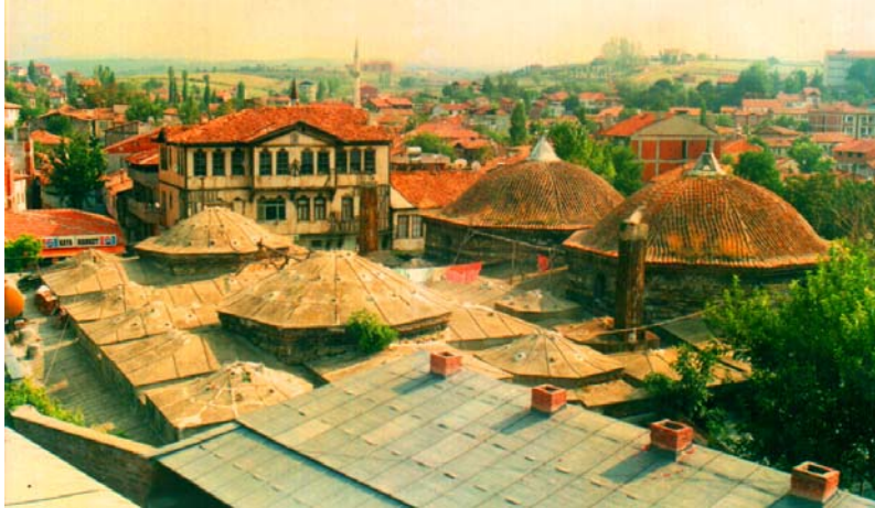
407. Vezirköprü - Çifte Hamam, güneydoğudan (restorasyon öncesi; 2002 yılı).
