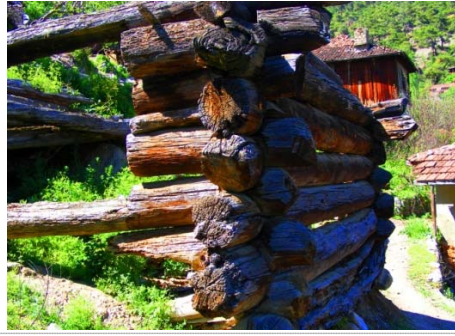
666. Vezirköprü / Çaltu Köyü'nde çantı yapı kalıntısında karaboğaz geçme detayı.
