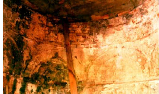
421. Vezirköprü - Yalı Hamamı, birinci hücre kubbe geçişleri.
