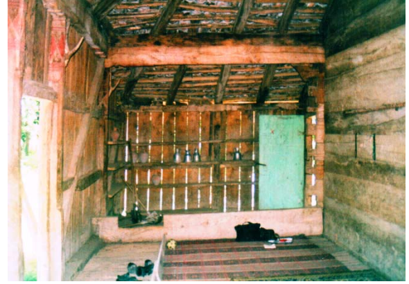
77. Terme / Dağdıralı Köyü Camii, son cemaat yeri, doğu kesim.
