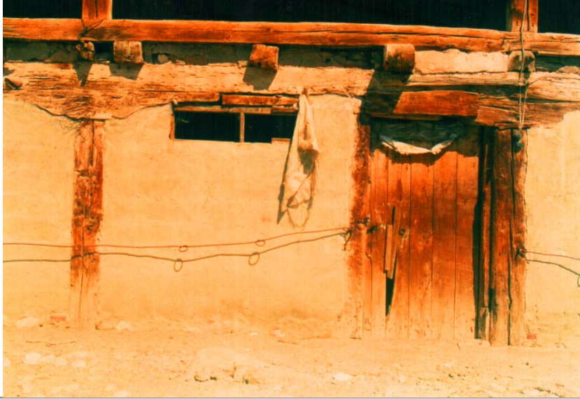
349. Vezirköprü - Taş Han, birinci kat batı kolda bir hücre (ahır) (restorasyondan önce).
