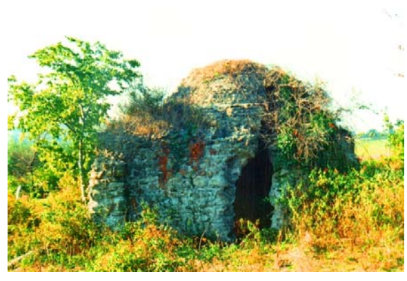
388. Bafra / Çetinkaya Beldesi - Hızır Bey Hamamı, kuzey cephe.
