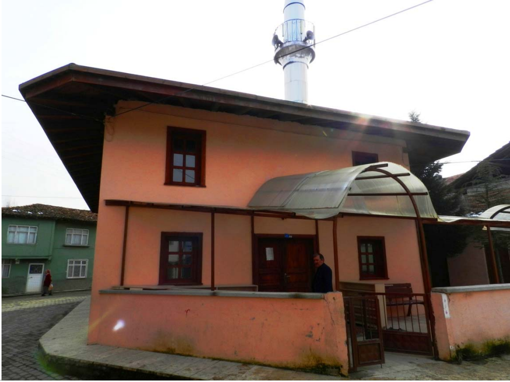
143. Vezirköprü - Yukarı Nalbantlı Camii, kuzey cephe.
