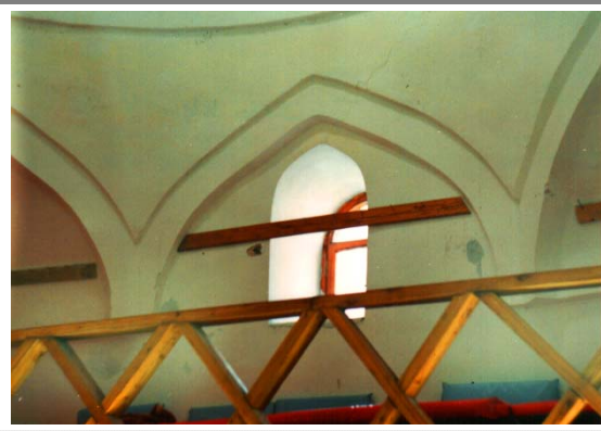
402. Havza - Erkekler Kaplıcası, soyunmalık kubbe geçişleri.
