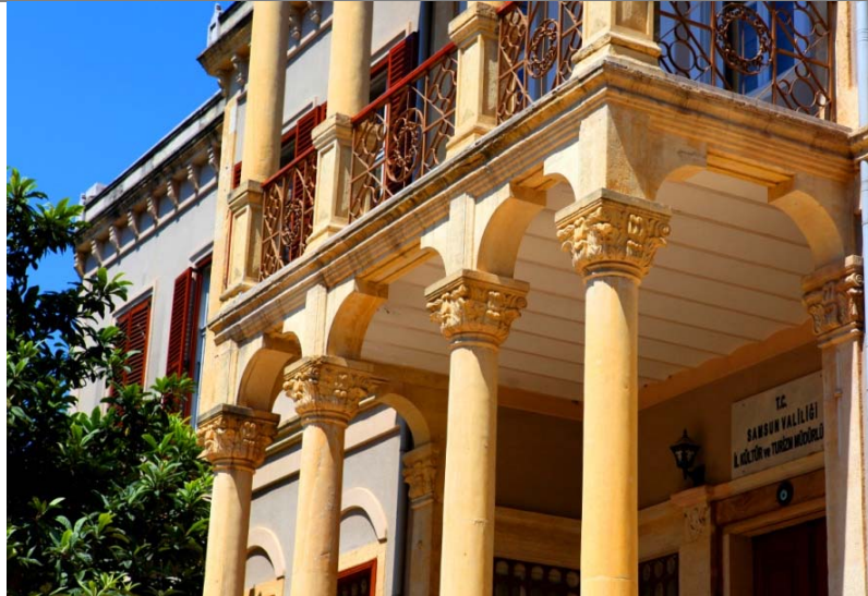
599. Kale Mahallesi'nde eski bir ev (Kültür ve Turizm Müdürlüğü - Eski Öğretmen Evi), ön cephe girişi.
