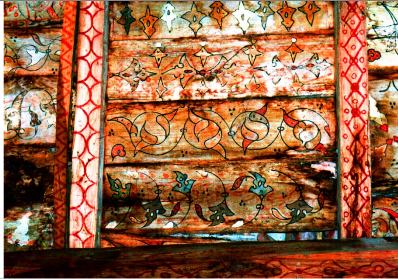
18. Çarşamba - Gökçeli Camii, çatısındaki kalemişi nakışlar (2008 restorasyonu öncesi).
