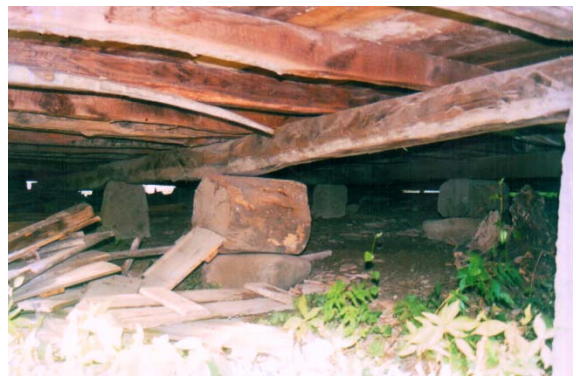
640. Salıpazarı - Kayadibi Camii kirişleme detayı.
