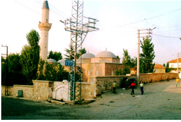
51. Vezirköprü - Taceddin İbrahim Paşa Camii, güneybatıdan.
