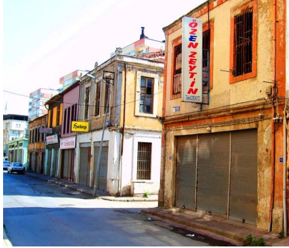
604. Hançerli Mahallesi'nde İskele Caddesi'nin doğu kolu üzerinde bulunan dükkânlar.
