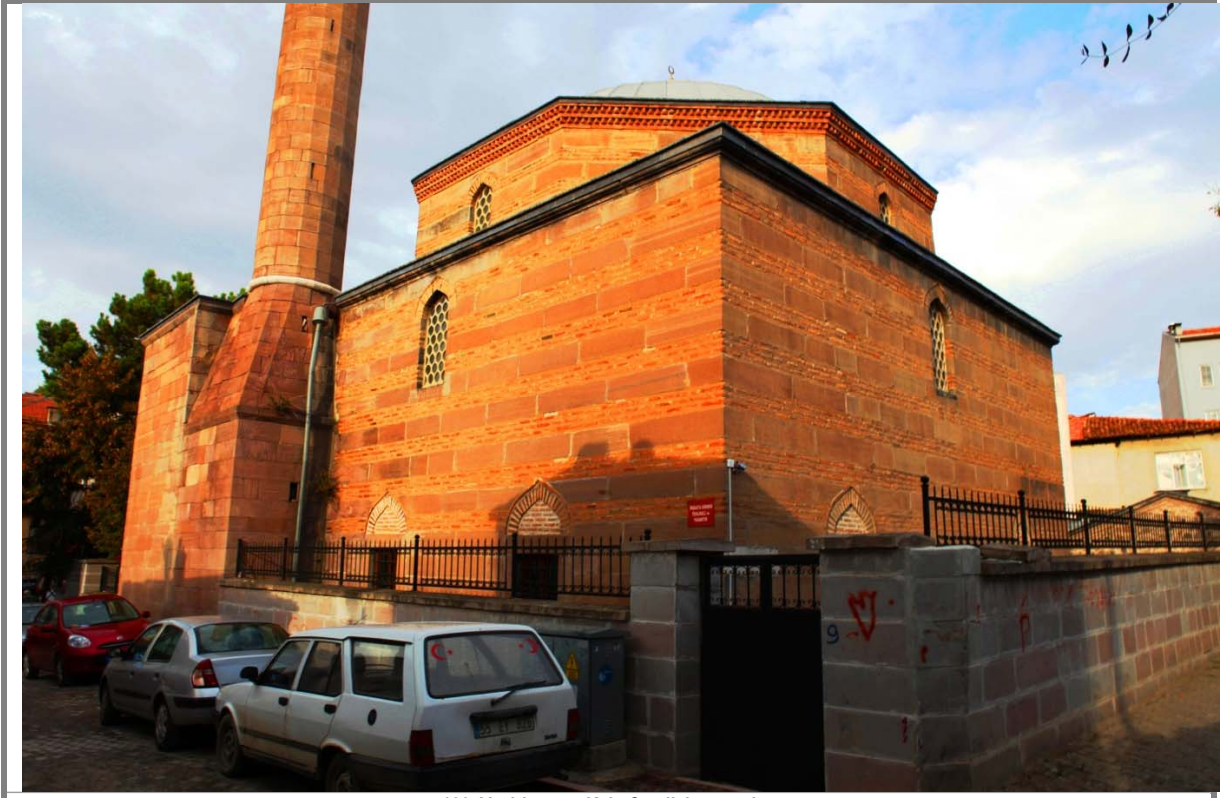
122. Vezirköprü - Kale Camii, batı cephe.
