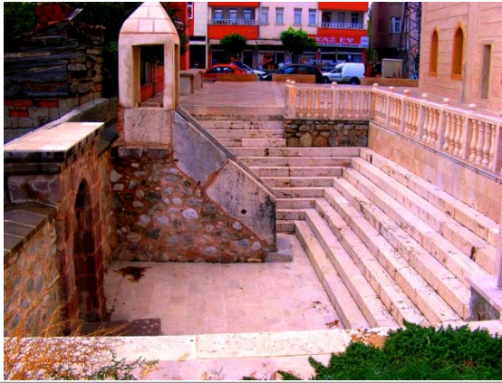
385. Vezirköprü - Köprülü Mehmet Paşa Namazgahı, doğudan.
