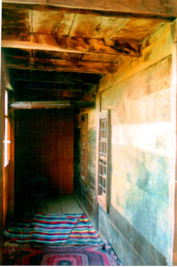
195. Çarşamba / Porsuk Köyü Camii, doğu revak, içten.
