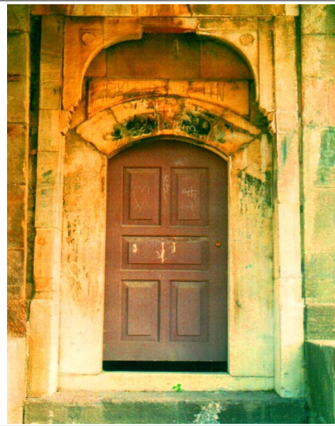
306. Lâdik - Sunullah Paşa Türbesi, kapısı.
