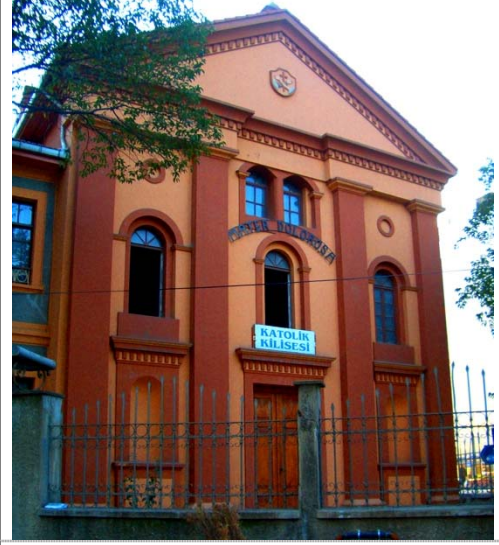
510. Mater Dolorosa Kilisesi, giriş cephesi.
