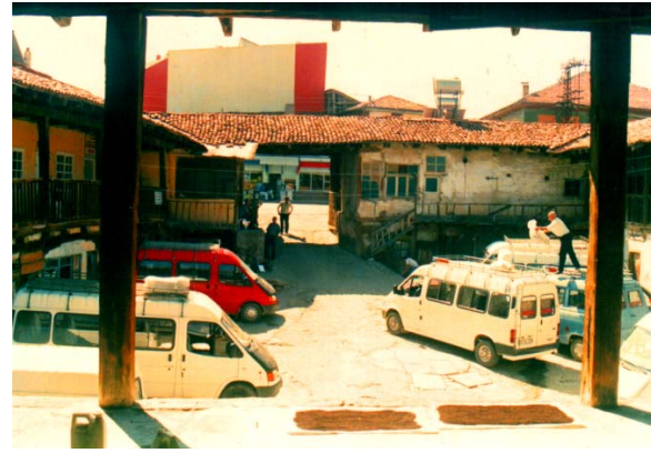
341. Vezirköprü - Taş Han, avlusu kuzeyden bakış (restorasyondan önce).
