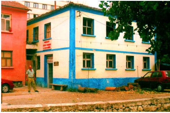
422. Bafra - Uzun Hamamı, soyunmalık cephesi.
