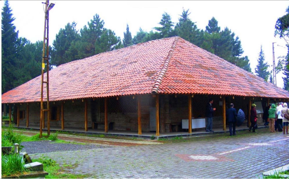
9. Çarşamba - Gökçeli Camii, batı cephe.
