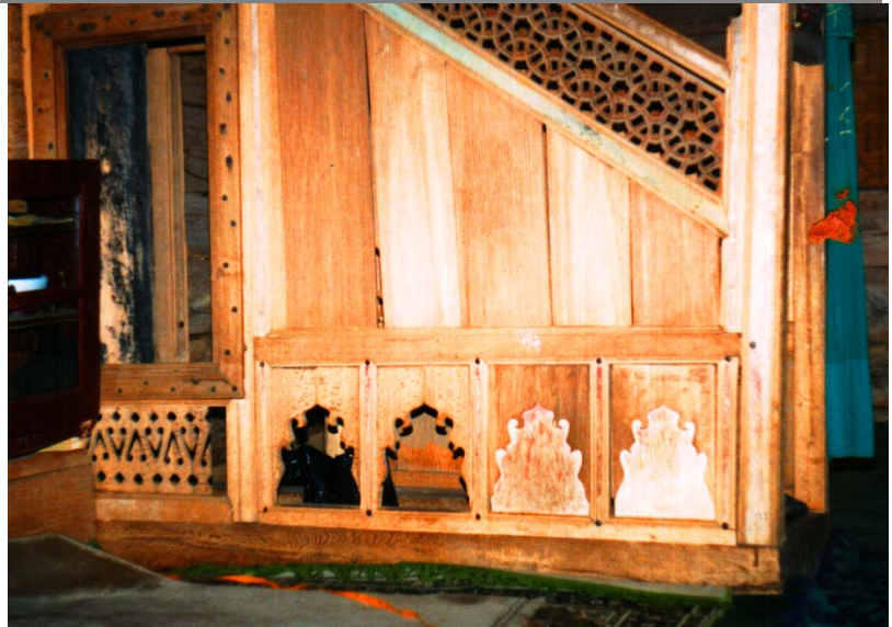
74. Terme / Yeni Cami Köyü - Eski Camii, minberi doğu yüzü.
