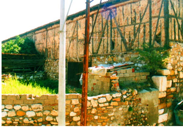
340. Vezirköprü - Taş Han, develik ve kuzey cephesi (restorasyondan önce).
