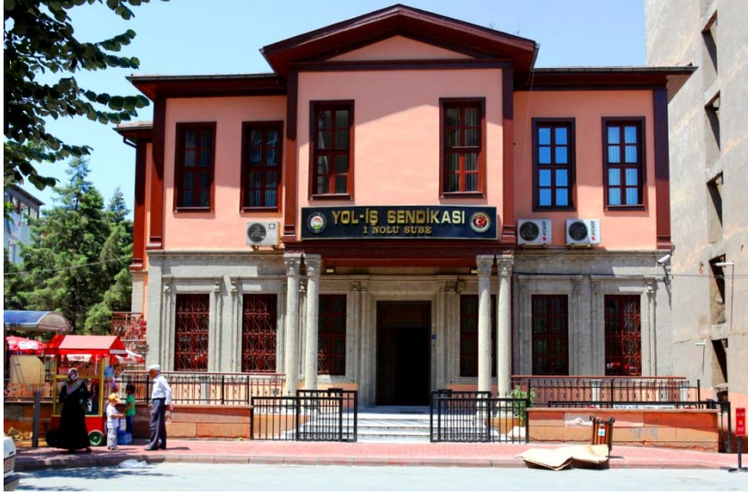
493. Eski Fransa Konsolosluğu (Yol- İş Sendikası), ön cephe.
