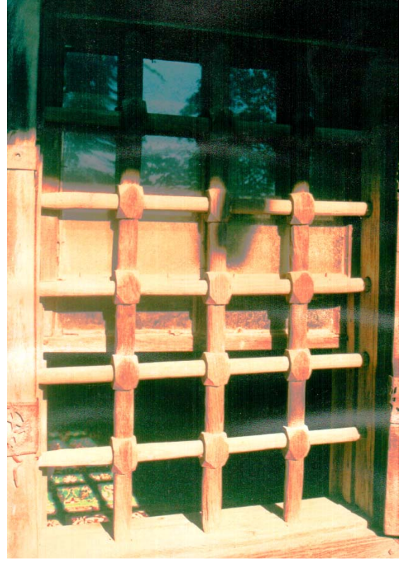
38. arşamba / Ordu Ky Camii, pencere muhafazası, ahşap lokmalı Őebeke.
