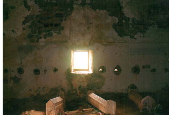
300. Bafra / Türbe Köyü - Emirza Bey Türbesi, batı duvarı (içten).
