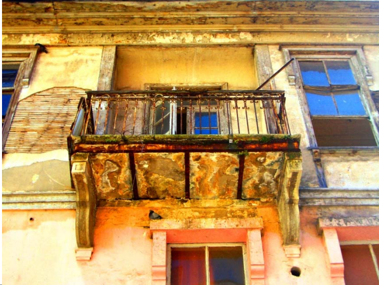
602. Ondokuzmayıs Mahallesi'nde bulunan 1908 tarihli evin balkon çıkması.
