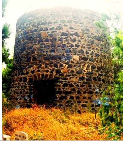
431. Tekkeköy - Çırakman Köyü - Yel Değirmeni (restorasyon öncesi; 2002 yılı).
