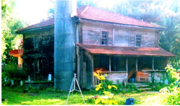
268. Terme / Aşağı Söğütlü Köyü Camii, kuzeydoğudan.
