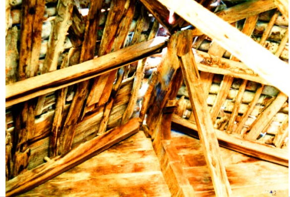
66. Çarşamba / Kuşhane Köyü Camii, çatı detayı.
