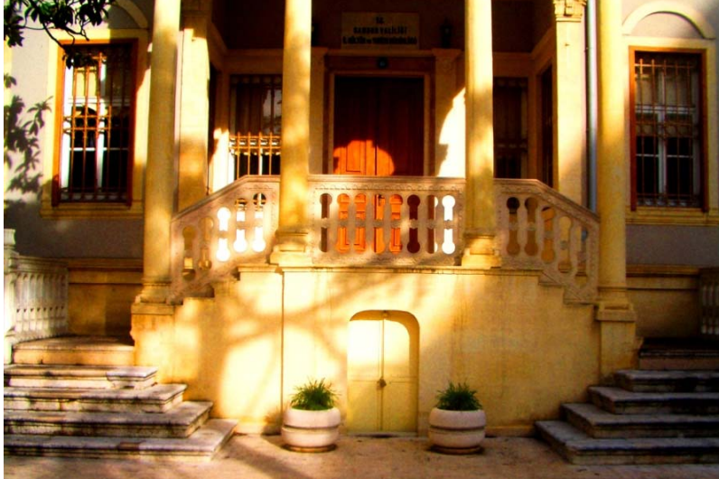
598. Kale Mahallesi'nde eski bir ev (Kültür ve Turizm Müdürlüğü - Eski Öğretmen Evi), ön cephe girişi.
