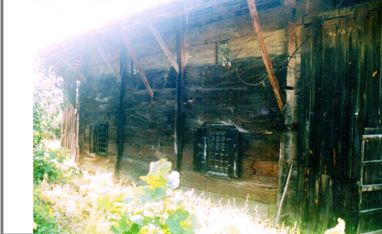
34. Çarşamba / Ordu Köyü Camii, kible duvarı.
