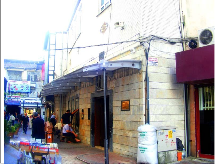
30. Samsun - Kale Camii, kuzey cephe.
