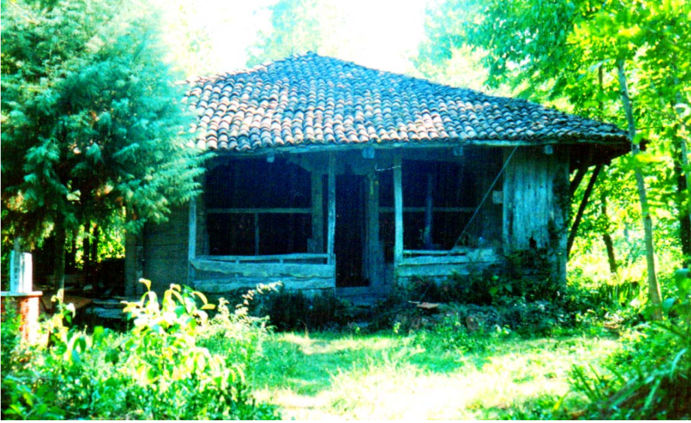
64. Çarşamba / Kuşhane Köyü Camii, kuzey cephe.
