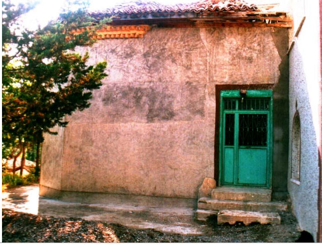
291. Havza / Dereköy - Veliyyüddin Bin Bereket Şah Türbesi, doğu (giriş) cephesi.
