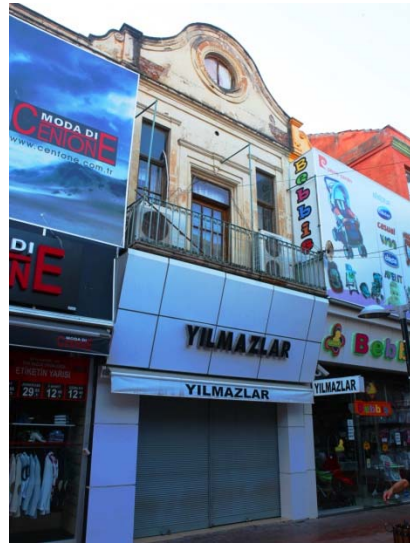
632. Kale Mahallesi'nde Mecidiye Caddesi'nin doğu kolu üzerinde yer alan bir dükkân.
