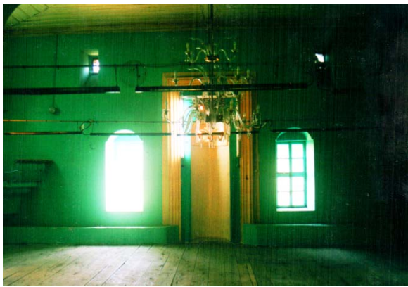
256. avza / Sivrikese Köyü Camii, harimi, kible duvarı.
