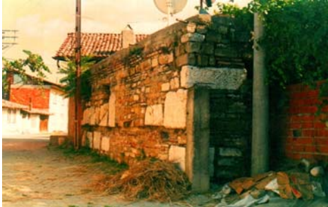
420. Vezirköprü - Yalı Hamamı, doğu cephe.
