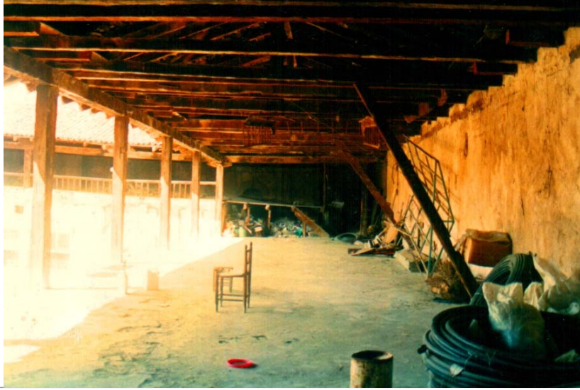
347. Vezirköprü - Taş Han, kuzey kol ikinci kat revakı (restorasyondan önce).
