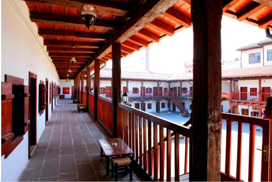
345. Vezirköprü - Taş Han, kuzeyden (restorasyondan sonra).
