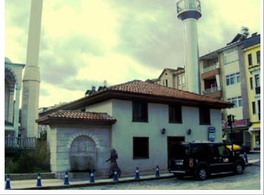
280. Vezirköprü - Namazgâh Camii, kuzey cephe.
