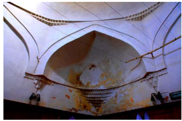
410. Vezirköprü - Çifte Hamam, soyunmalık kubbe geçişleri.
