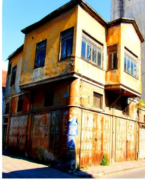
597. Haçerli Mahallesi'nde alt katı dükkân olarak tasarlanmış eski bir ev.
