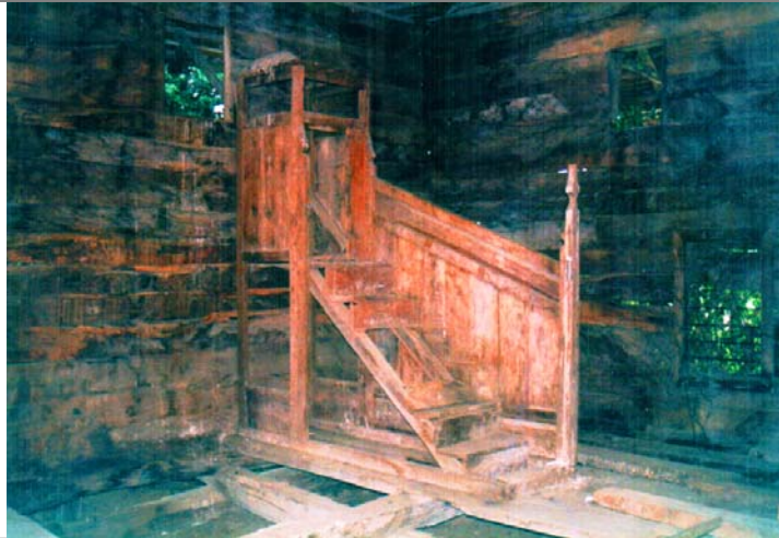
142. Ondokuzmayıs - Fatih Camii, minberi (restorasyondan önceki hali).
