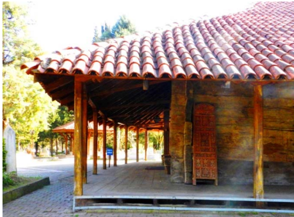
10. Çarşamba - Gökçeli Camii, kuzey revak (2008 restorasyonu öncesi).
