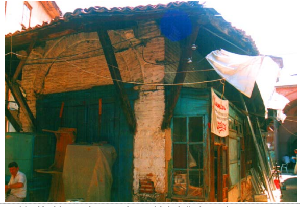
367. Vezirköprü Arastasi, kuzey blok doğu kanat (restorasyon öncesi).
