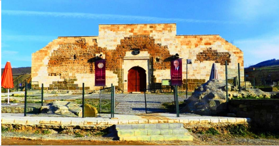
326. Kavak - Çakallı Beldesi - Çakallı Han, giriş (güney) cephesi.
