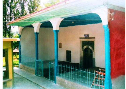
216. Havza / Cevizlik Köyü Camii, kuzey cephe.
