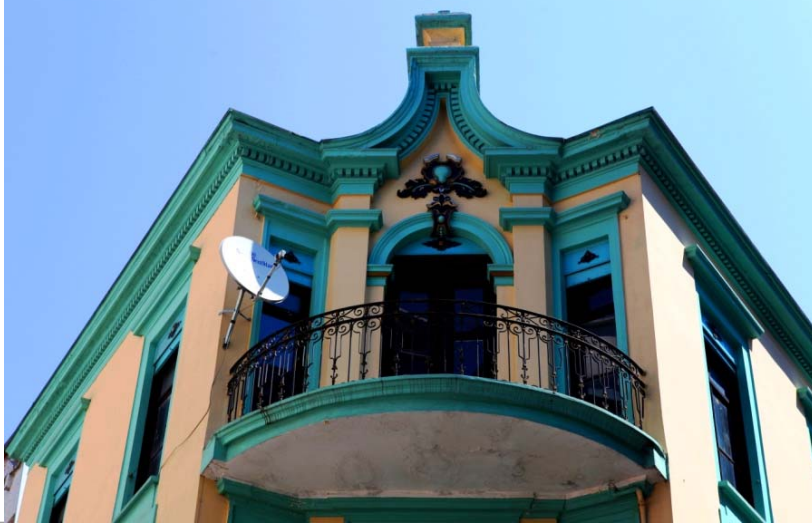
496. Eski Almanya Konsolosluğu, giriş cephesi detay.
