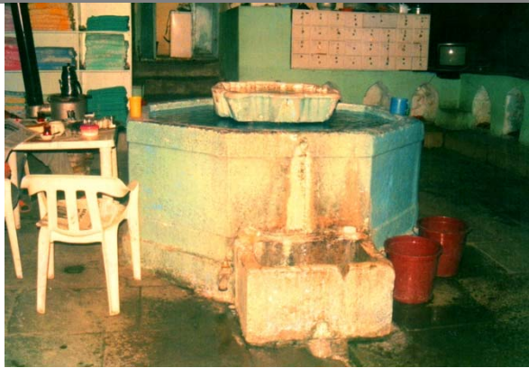
417. Vezirköprü - Kale Hamamı, soyunmalık şadırvanı.
