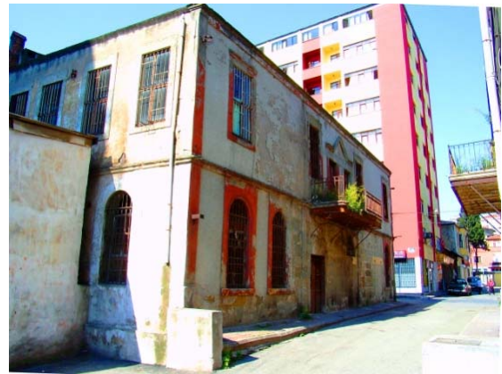
608. Hançerli Mahallesi'nde İskele Caddesi doğu kolu üzerinde bulunan dükkânlardan birisi.
