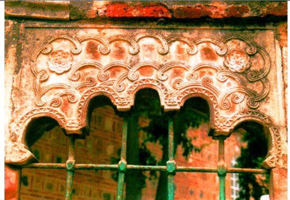
116. Bafra - Ulu Camii, haziresinin duvar pencerelerinden detay (2002 restorasyon öncesi).
