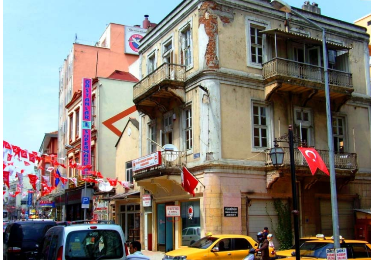
626. Kale Mahallesi'nde Kazım Paşa Caddesi'nin doğu kolu üzerinde yer alan bir dükkân.
