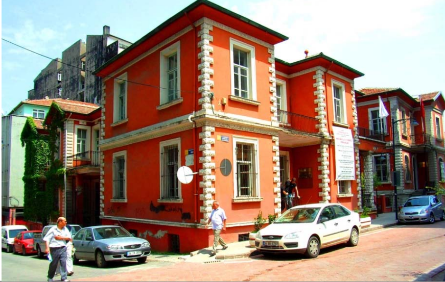
572. Karadeniz Mahallesi'nde Şahinzâdeler Konağı (Samsun Büyükşehir Belediyesi Konservatuarı, Kültür ve Sanat Müdürlüğü).
