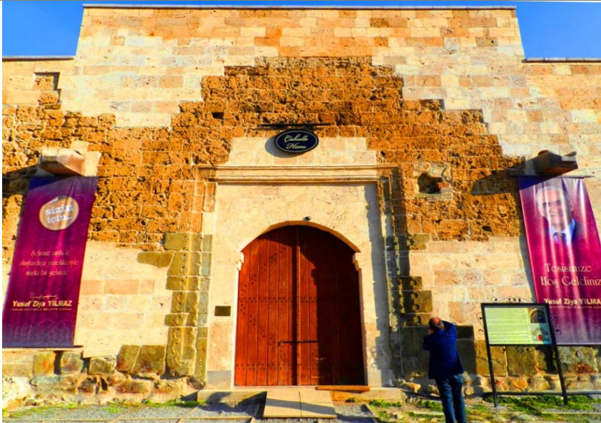
327. Kavak - Çakallı Beldesi - Çakallı Han, kapalı kesim giriş cephesi.
