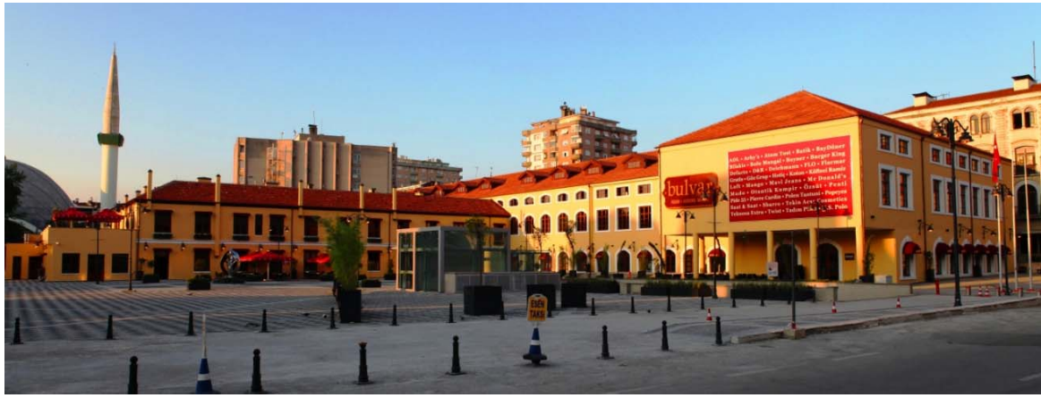
470. Eski Tekel Sigara Fabrikası, ana bina.
