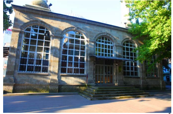
233. Samsun - Ulu Camii, kuzey cephe.
