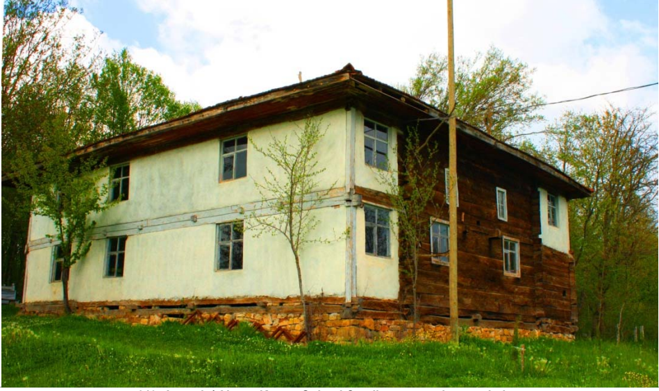
149. Asarcık / Akyazı Köyü - Gököl Camii, güney ve batı cepheler.
