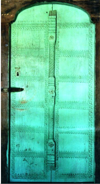
78 Terme / Dağdıralı Köyü Camii, harime açılan kapı.
