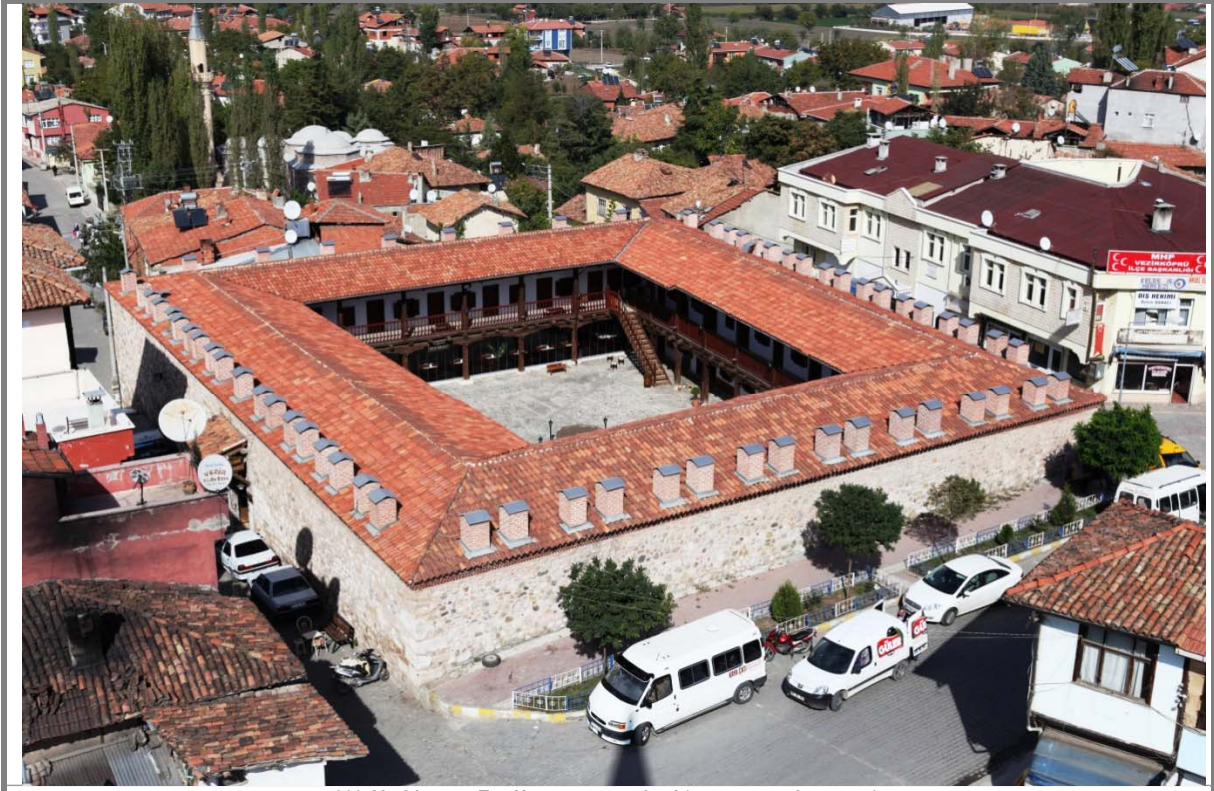
339. Vezirköprü - Taş Han, güney cephesi (restorasyondan sonra).
