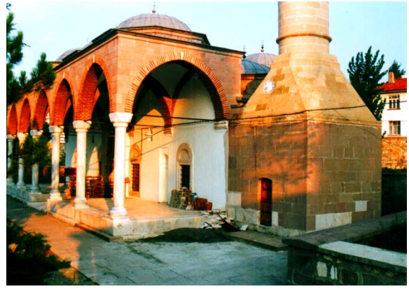
52. Vezirköprü - Taceddin İbrahim Paşa Camii, son cemaat yeri.
