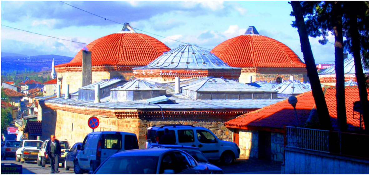
Foto. 31. Vezirköprü Çifte Hamam, güneybatıdan.
