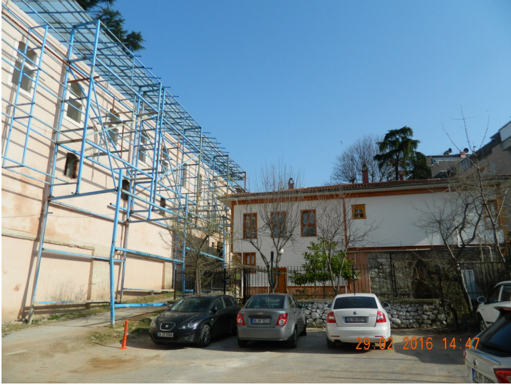
Aşçıbaşı Konağı, arka yüz, kuzey cephesi.
