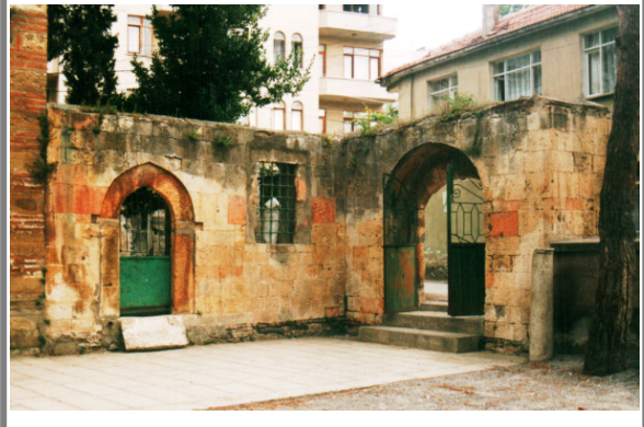
Foto. 6. Bafra Ulu Camii, avlu kapısı ve hazire girişi (2002 restorasyon öncesi).
