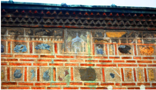
Foto. 9. Bafra Ulu Camii, kible duvarı saçak altı, detay (cami tasviri).
