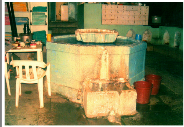
Foto. 36. Vezirköprü Kale Hamamı, soyunmalık şadırvanı.
