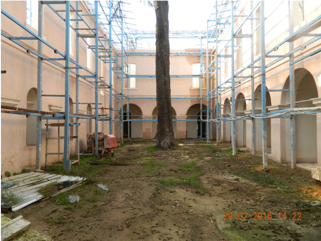
Nûrbânu Sultan Kervansarayı, sol blok.
