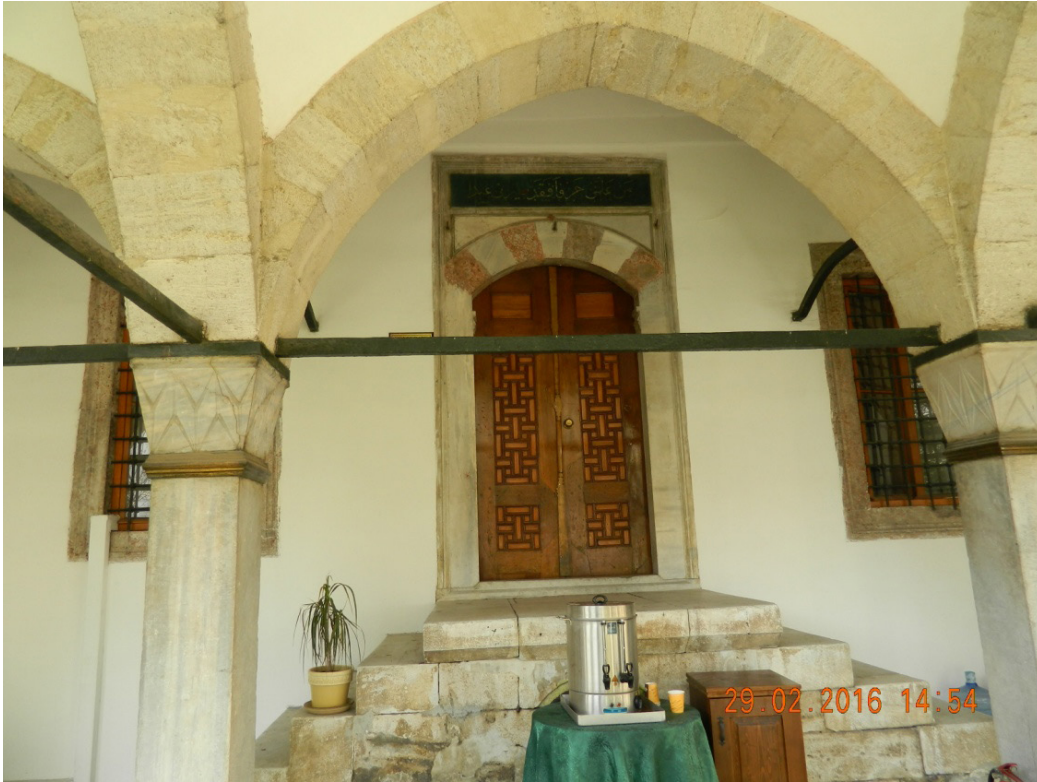
Nûrbânu ( Atîk ) Valide Sultan Medresesi,Dar 'ülkurasına giriş merdivenleri ve kapısı.
