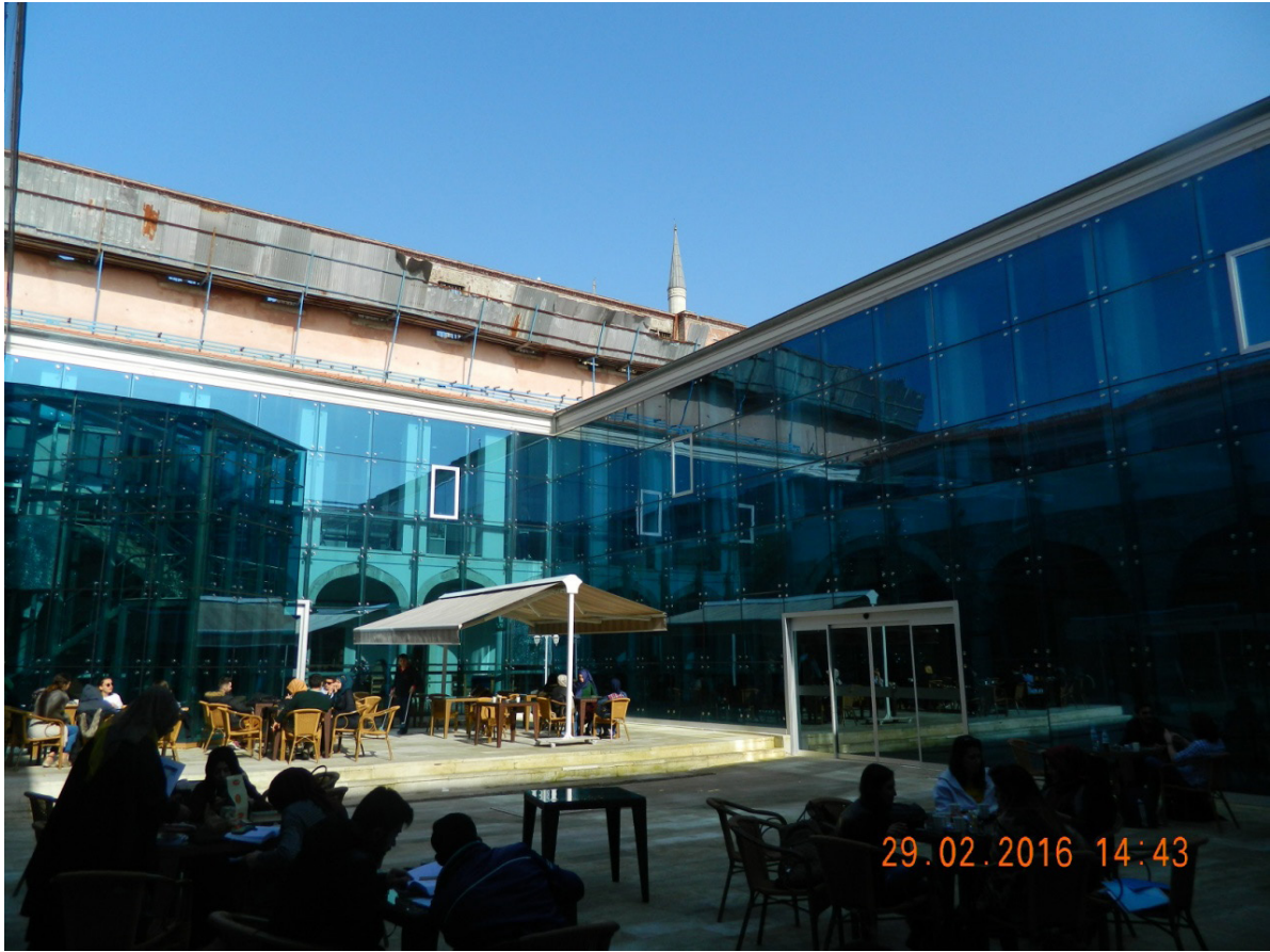
FSM.Üni. Ed. Fak. Türk Dili Bölümü tarafından kullanılan restore edilerek avlusu camla kapanmış Dar'üşşifa.
